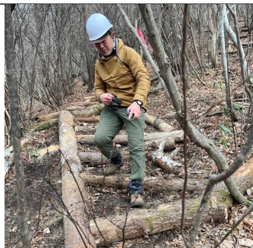
修復後 丸太で土留めと足場を確保している
