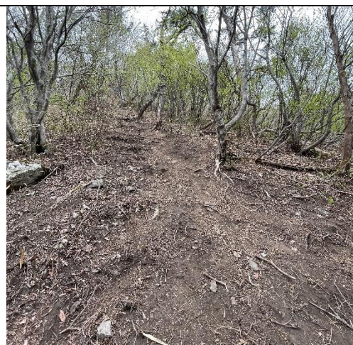
修復前 急斜面で土が流出している
