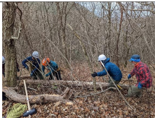
修復（土留め）に使用する丸太の運搬
