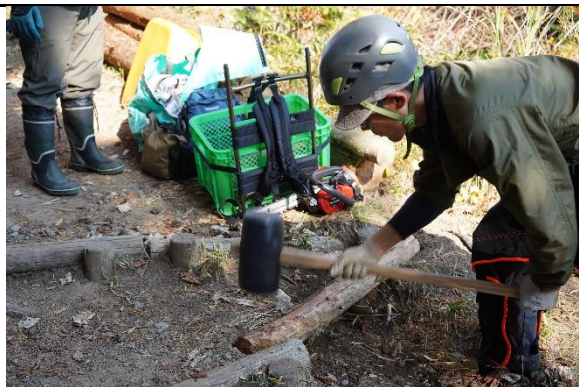
土留めの丸太を登山道に設置中（予防処置）
