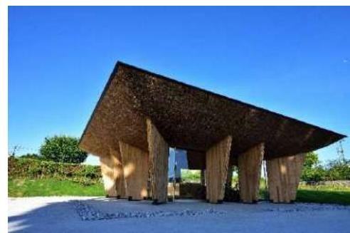
グリーナブルヒルゼンは、建築家の隈研吾氏が設計監修した施設で、木材は全て真庭産・製造も真庭でされたCLTを使用しており、東京の晴海で一度活用され、2021年7月に移築したものです。解体ではなく、移築可能なサスティナブルな建築は、都市と地方との資源・文化の交流を表すものとして、ブランドの象徴となっています。"GREENable HIRUZEN"を象徴する『風の葉』はCLTのパネルを360枚使い、木目の美しさを最大限生かしたデザインとなっています。
