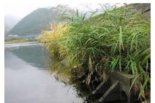
コンクリート二次製品メーカーの環境保全ブロック、CO2吸収ブロックなど見学します。ランデスは、川をまもる(護岸機能)+緑が育つ(植生機能)+魚がすむ(魚巣機能)の自然環境に優しい商品を製造しています。二酸化炭素を吸い込んで固まる「スイコム」は、CO2排出量をゼロ以下にする、持続可能な環境配慮型コンクリートとして注目されています。
