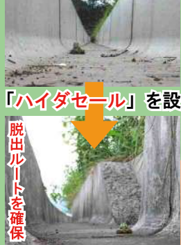
「ハイダセル」を設置 脱出ルートを確保
